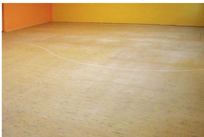
Původní stav podlahy
