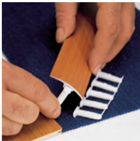
vložte hmoždinku do kanálku zespodu profilu a upravte pozici tak aby se kryla s dírami podlahy
