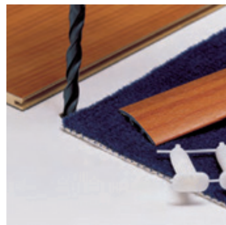
provrtajte podlahu vrtákem o průměru 6mm
