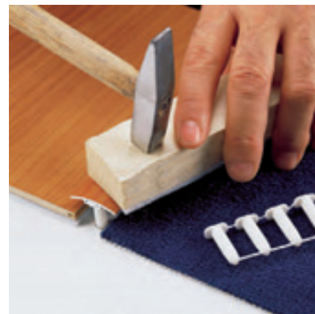
položte za použití kousku dřeva a kladívka
