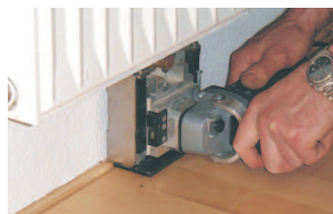
Řezání dilatačních spár pod radiátory
